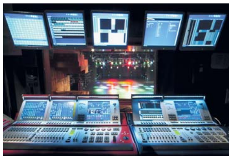
10. ábra. Fesztivál Színház fényvezérlő helyisége (Compulite - Vector vezérlőpultok)
