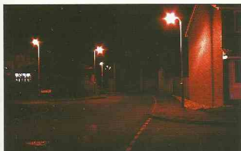
5. ábra: A kisnyomású nátriumlámpás (rég) berendezés
