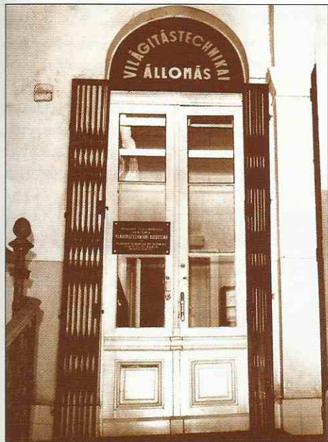
1. A Világítástechnikai Állomás bejárata
