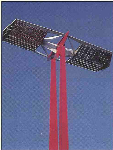
1. ábra A Lágymányosi Dunahíd világításának szekunder tükrrendszer
