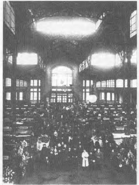
A Rákóczi téri csarnok ívlámpás világítása (1890-es évek)
