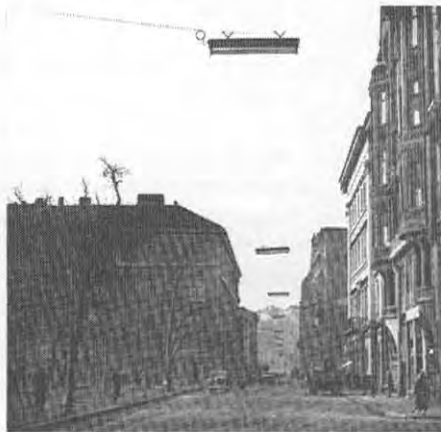
Az első fénycsőes közvilágítás, útközépre helyezett, 4x65W-os, EKA lámpatesttel a budapesti József Attila utcában (1957)
