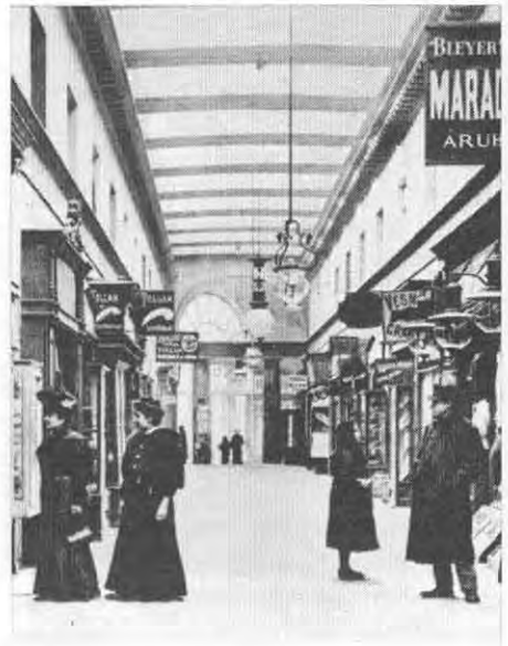
A régi Párizsi-udvar világítása különböző ívlámpákkal (1900 körül)
