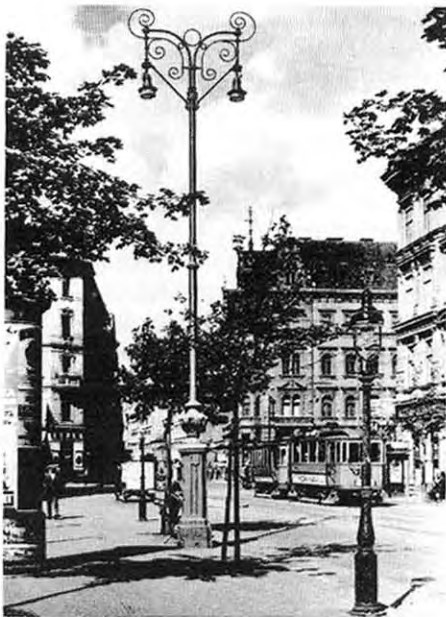
Közvilágítási egység 10 méter magas Eötvös-típusú öntöttvas kandeláber, kétkarú, nagyteljesítményű izzólámpákkal, zománc ernyős, üveghengeres lámpatesttel. 1910-20-as évek
