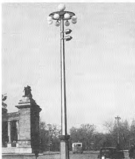
Art deco stílusú közvilágítási oszlop a budapesti Hősök terén, 9 db opál gömb, 10 m fénypontmagasság
