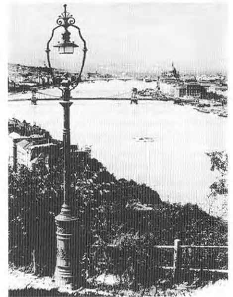
Közvilágítási egység, öntöttvas kandeláber, zománcernyős, üveghengeres lámpatest kis fénypontmagasság (3,5 m) 1910-1920-as évek
