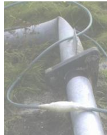
Az oszlop nem megfelelően lett rögzítve, ezért kiszakadt a tervezett törés helyett
